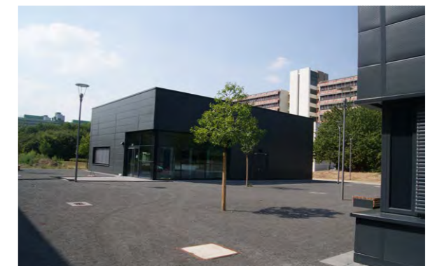
Der Neubau des Geothermiezentrums im Jahr 2013
