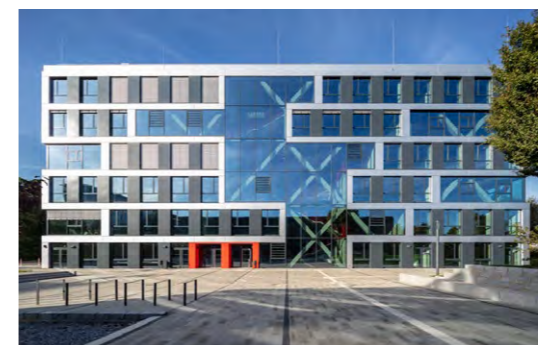
Das neue H-Gebäude, 2020
